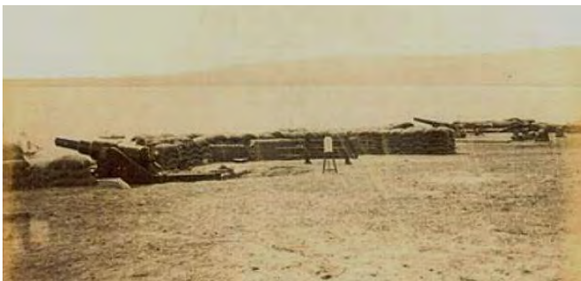
Vista parcial de la batería Alta del morro de Arica, se puede apreciar un cañón Vavasasseur de 9" y un cañón Parrot de 6,4". Fotografía Díaz y Spencer, tomada de la página web http://hlzarica.cl.tripod.com/capitulo_ii.htm .
