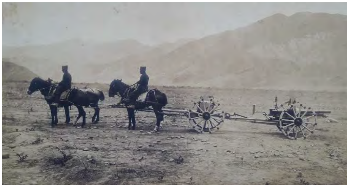
FIGURA 6. Cañón de campaña de tiro rápido Krupp de 70 mm, en posición de macha con su avantrén con la caja de municiones, jalado por cuatro caballos. Foto, Memoria de la Comisión Examinadora de cañones de campaña (1905).
