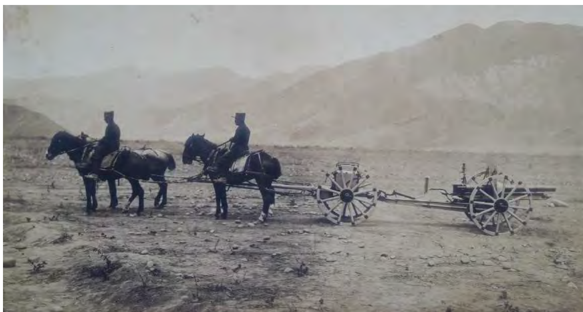
FIGURA 6. Cañón de campaña de tiro rápido Krupp de 70 mm, en posición de macha con su avantrén con la caja de municiones, jalado por cuatro caballos. Foto, Memoria de la Comisión Examinadora de cañones de campaña (1905).
